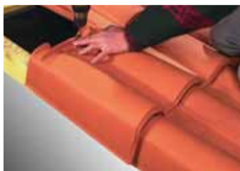
Fixation des tuiles de rive à rabat gauche à recouvrement en rive latérale gauche par vis et rondelle d'étanchéité.
