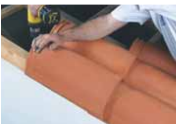
Fixation des rives à rabat à recouvrement en rive latérale gauche par vis et rondelle d'étanchéité.
