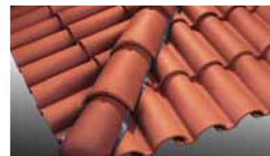
Arêtiers et abouts d'arêtier pureau variable à emboîtement posés à sec, sur closoir ventilé, sans emploi de mortier.
