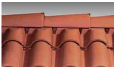
Faitage réalisé à sec avec tuiles sous-faîtières et faîtières, ne nécessitant pas d'étanchéité complémentaire, sauf protection neige poudreuse.
