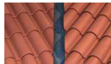
Les tuiles sont tranchées biaisées parallèlement à l'axe de la noue.
