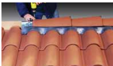
Après mise en place du closoir ventilé, les faîtières sont fixées par crochet adapté au modèle, vissé dans la lisse de rehausse.
