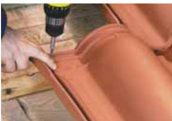
Fixation des tuiles en plain carré pour tenue au vent par vis et rondelle d'étanchéité.
