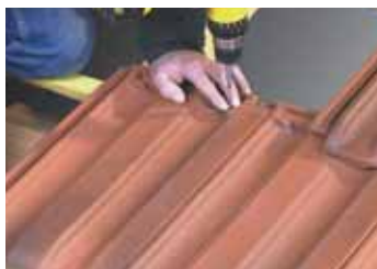
Fixation des tuiles en plain carré pour tenue à forte pente, par vis et rondelle d'étanchéité.
