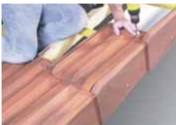
Fixation des tuiles en rives latérales gauche et droite par vis et rondelle d'étanchéité.
